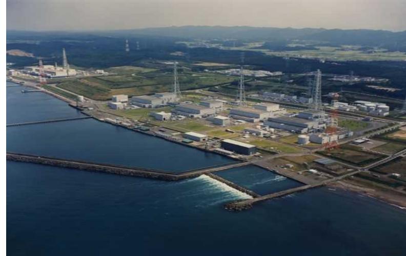
柏崎刈羽原子力発電所
